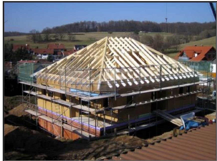
Dachstuhl aufgeschlagen
