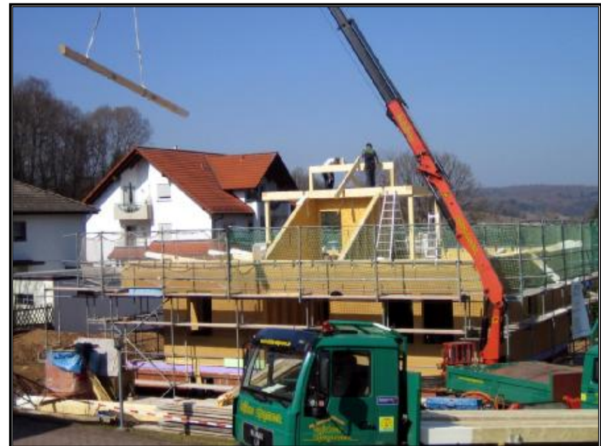
Dachstuhl aufschlagen
