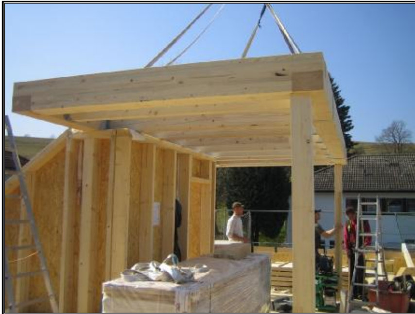
Dachstuhl aufschlagen
